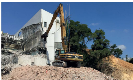
以油壓夾混凝土機進行拆卸可降低產生的聲浪和震動。（資料圖片）
